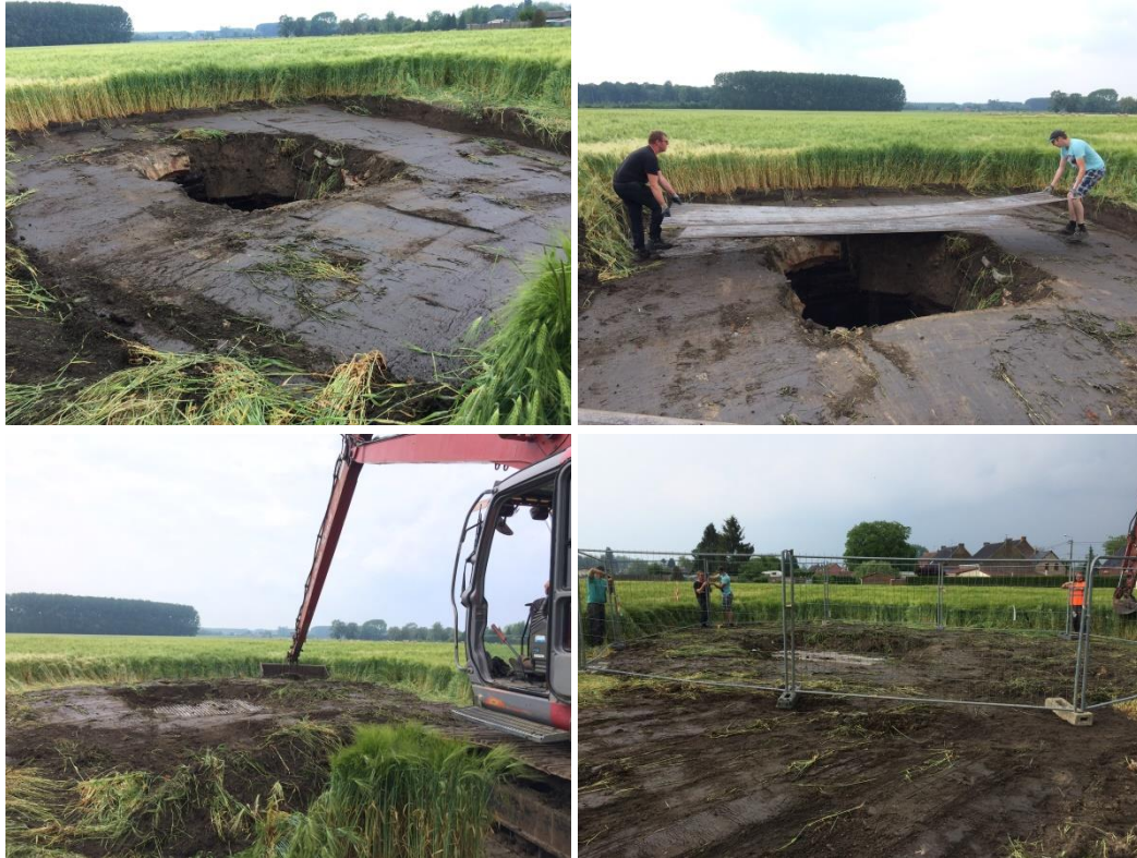
Figure 5 - Mesures de sécurité publique prises aux abords du puits (Photos UTAM Est).
