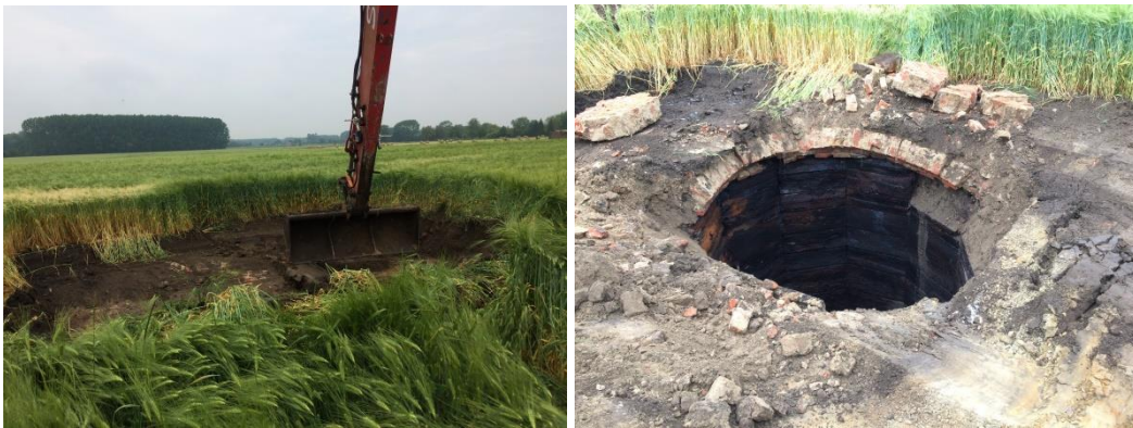
Figure 2 - Voûte maçonnée mise à nu en tête de puits (à gauche), puis déconstruite (à droite)
